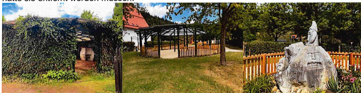
Sanierung des Pavillons (li: vorher, re: nachher; Fotos: lenaplant), eingezäunte Zwergenskulptur
